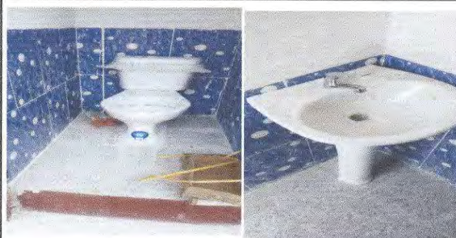
Foto 4: Sustitución inodoro, sustitución lavamanos
