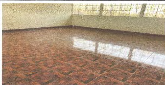
Foto 5: Sustitucion de piso de torta de cemento por ceramico.
