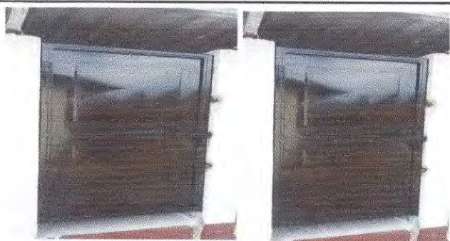
Foto 5: Sustitución de puertas en servicio sanitario
