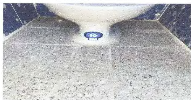
Foto 6: Sustitución de piso de torta de concreto por piso ceramico
