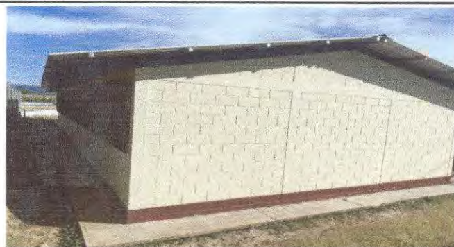
Foto 3: pintura en muros de exteriores e interiores.
