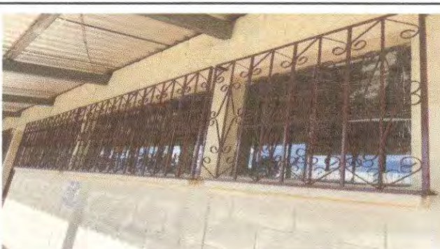
Foto 4: Intalación de vidrios y matenimiento en balcones pintura.
