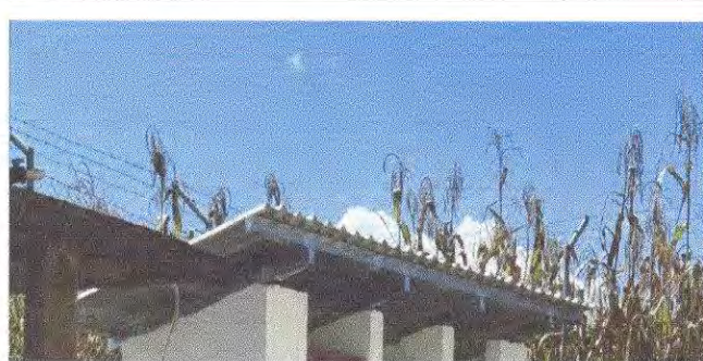
Foto 2: Sustitución de estructura de soporte de madera por metal (3x2 pulgadas)
