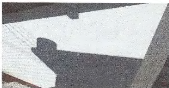
Foto 3: Repello en muro
